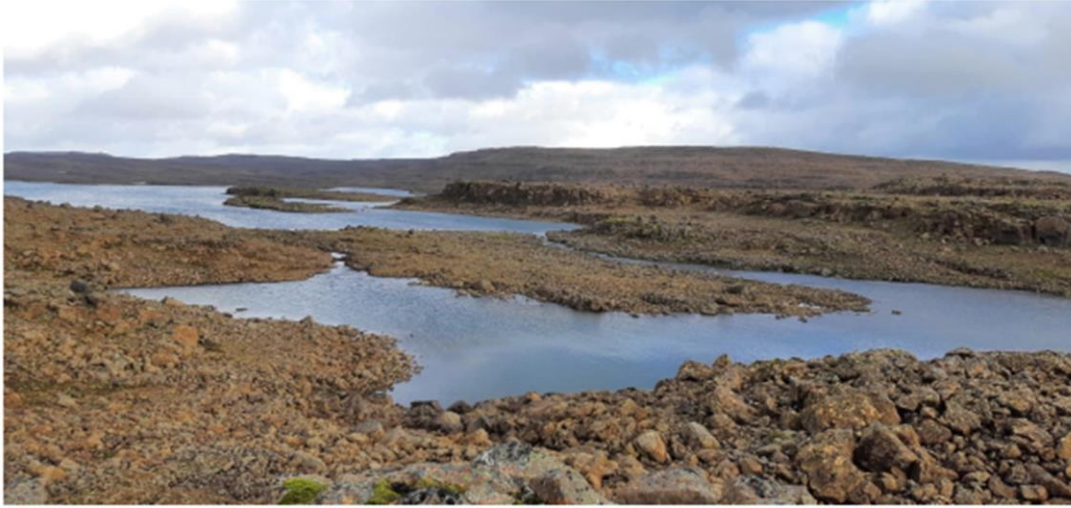
Mynd 31 Útrennsli Hólmavatns og stíflustæði þvert yfir miðja mynd.
